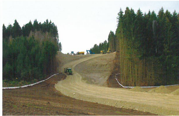
Grünbrücke - März 2016 Erdarbeiten
